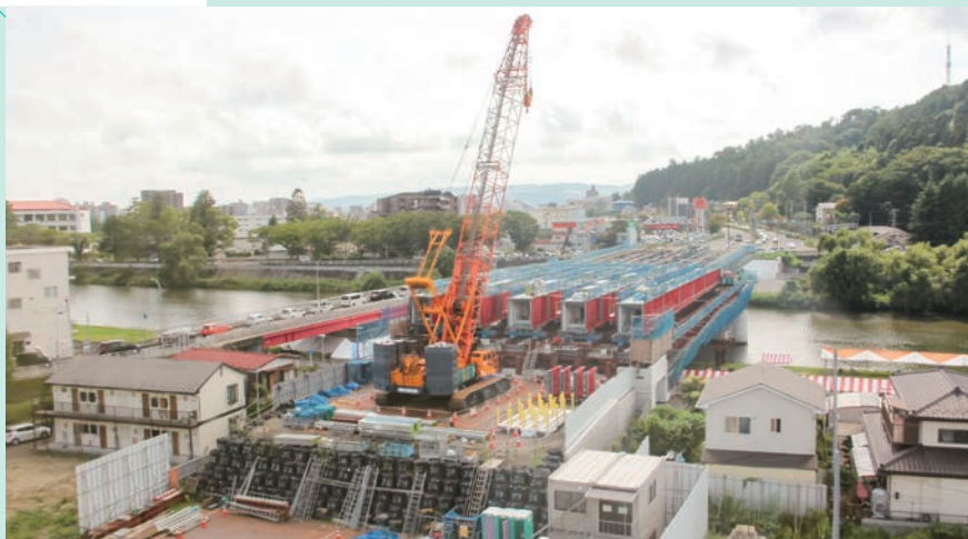
工事中の宮沢橋と現在の宮沢橋（左）。国道286号方面を臨む
