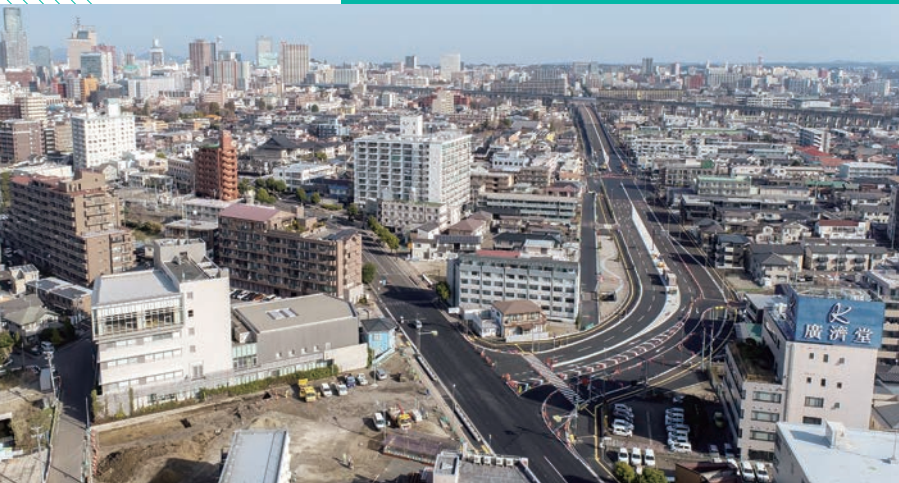
2023年3月に開通した南鍛冶町・舟丁工区（提供＝仙台市）
