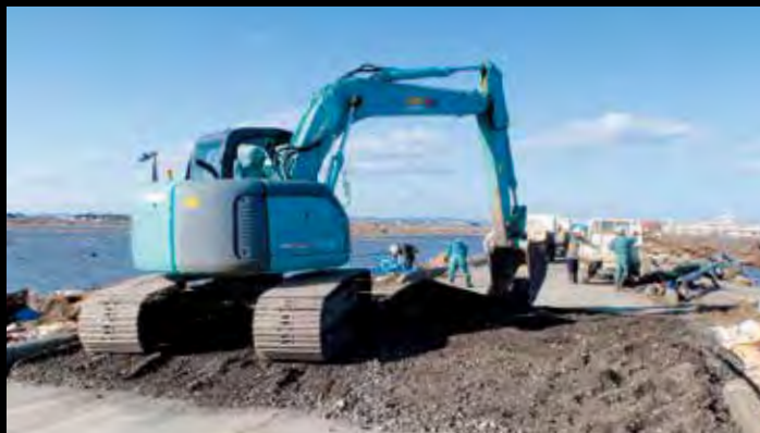
津波で分断された県道塩釜亘理線の緊急復旧（3月18日）
