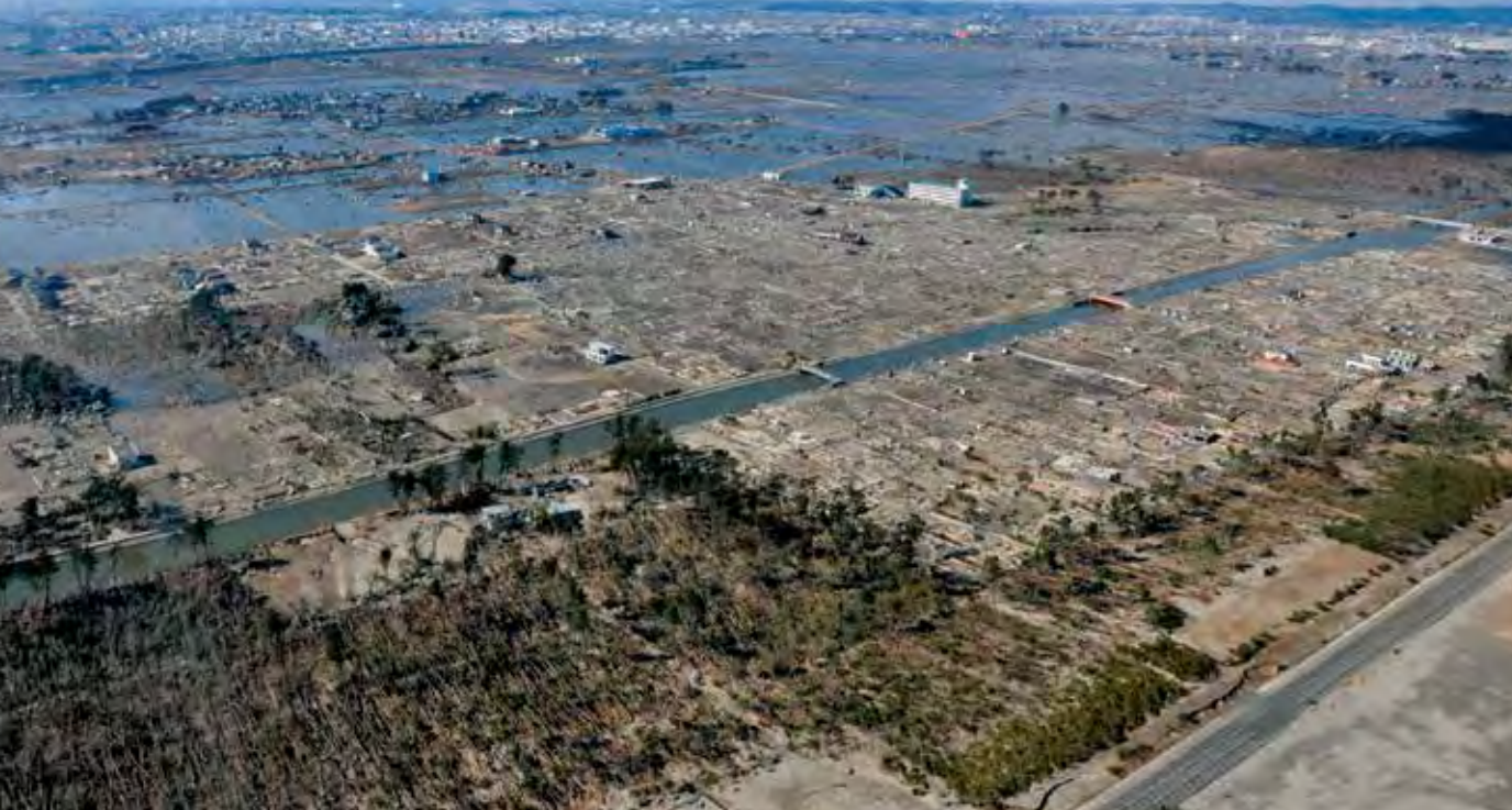
盛土構造が多くの命を救った仙台東部道路
