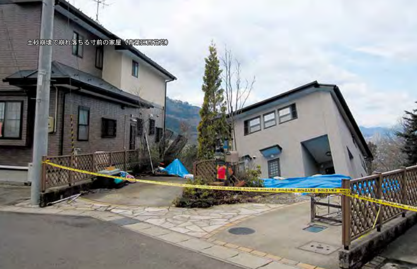
地割れにより庭が沈下（青葉区折立）
