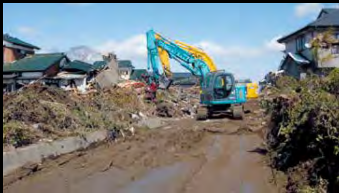
若林区井土地区の道路啓開（3月18日）
