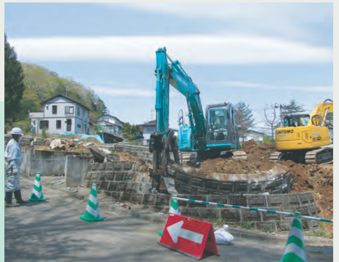
■着工した折立五丁目地区の宅地復旧工事(5月)
