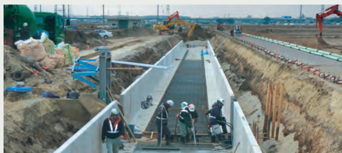
■排水路復旧工
