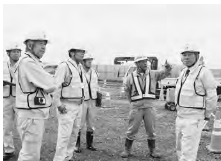
伸和興業施工の「東部地域防災集団移転促進事業 田子西隣接地区基盤整備工事(北工区)」現場で10/17に実施した雇用・安全管理パトロール
