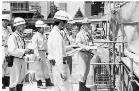
仙台市・仙台労基署との合同パトロール(7/2)。現場は「元寺小路福室線上部工架設工事」。施工は東日本コンクリート
