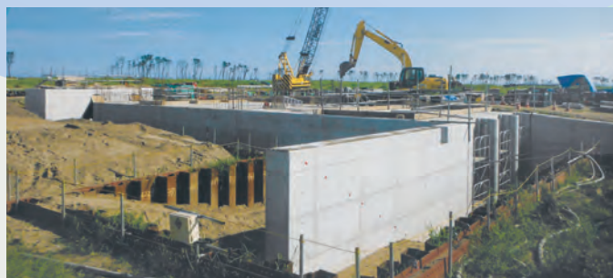
■排水機場復旧工
