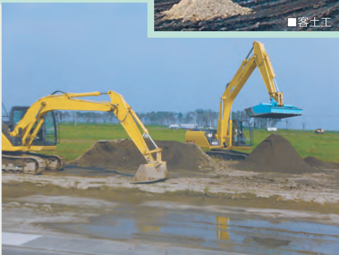
■農地復旧・雑物除去工
