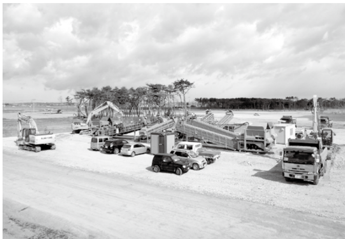
■津波堆積土砂の改良状況（仙台市提供）
