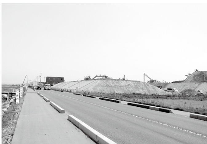
■かさ上げ道路の盛土状況（14年6月）（仙台市提供）
