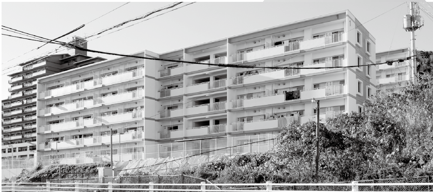
■鹿野復興公営住宅（施工＝佐々良建設・石井組JV）
