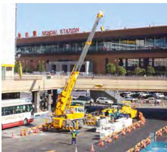
▼地上ではクレーンを使って資材を降ろす作業が続く
