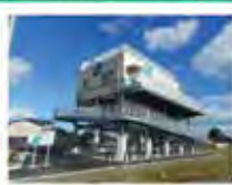
津波避難タワー
