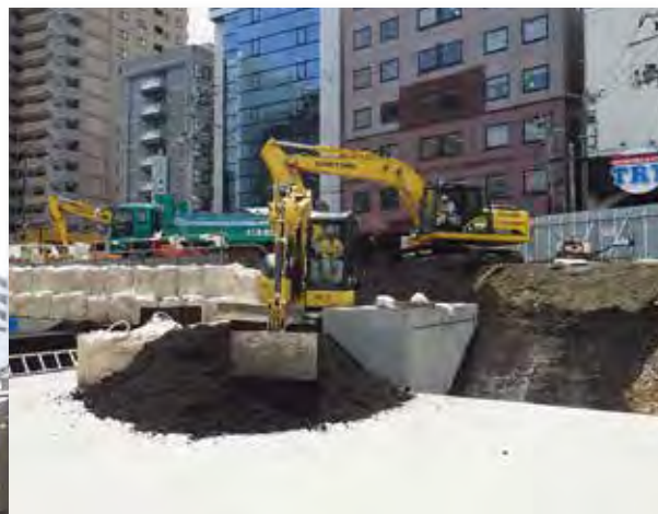
大型建設機械で貯水槽を埋め戻す
