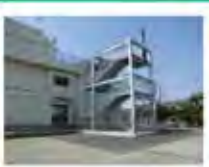
津波避難屋外階段
