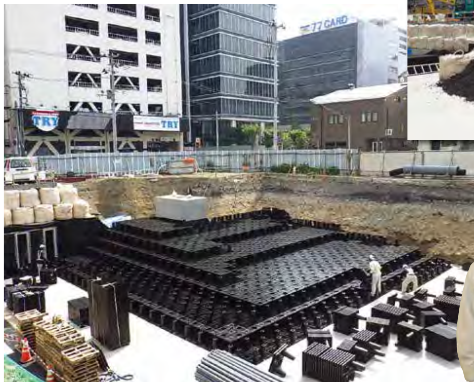
プラスチックユニットで貯水槽を施工
