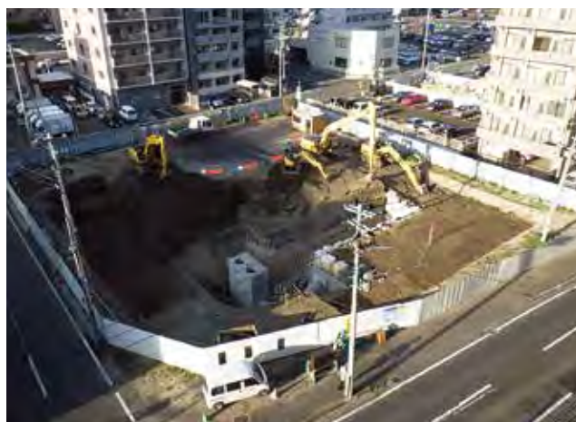
施工中の現場全景
