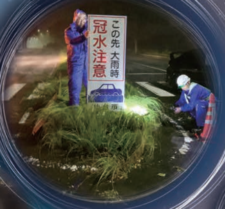
豪雨時の緊急出動。河川 氾濫や冠水被害から市民 生活を守る(上・長谷 川建設、下・赤坂建設)
