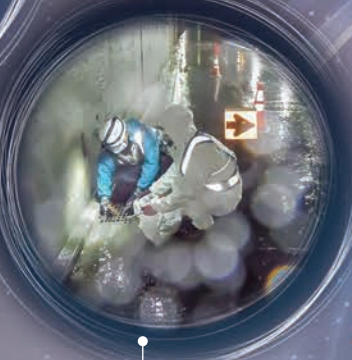
アンダーパスの冠水 による夜間の緊急 出動。集水枡詰りの 解消作業(高工)
