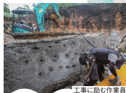
既存施設の解体後、これから総合獣舎の建設が本格化します
